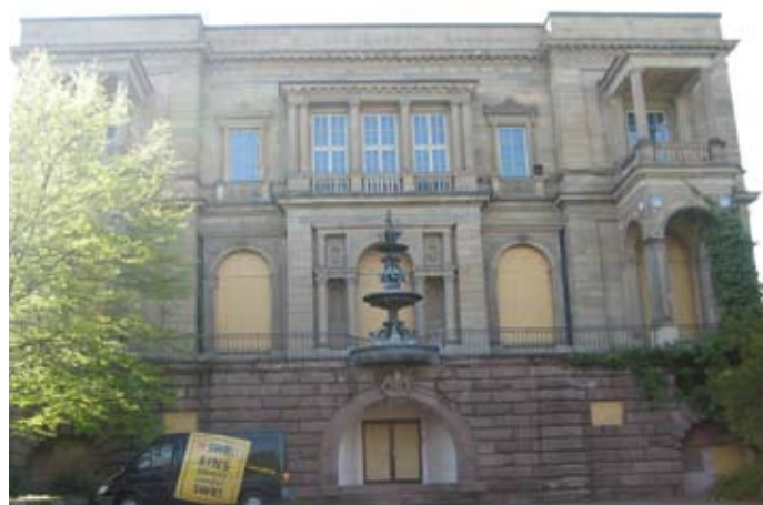
Die Villa Berg soll nach der Sanierung öffentlich genutzt werden. Der Park rund um die Villa soll rekultiviert werden.
